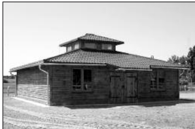
W Miechcinie wybudowano drewniany obiekt, który będzie pełnił funkcję Wiejskiego Centrum Rekreacji i Wypoczynku. Inwestycję gminną wykonał Zakład Usług Leśnych Koszyczarek Hieronim z Luboni za kwotę 68. 878, 85 zł brutto. PK
